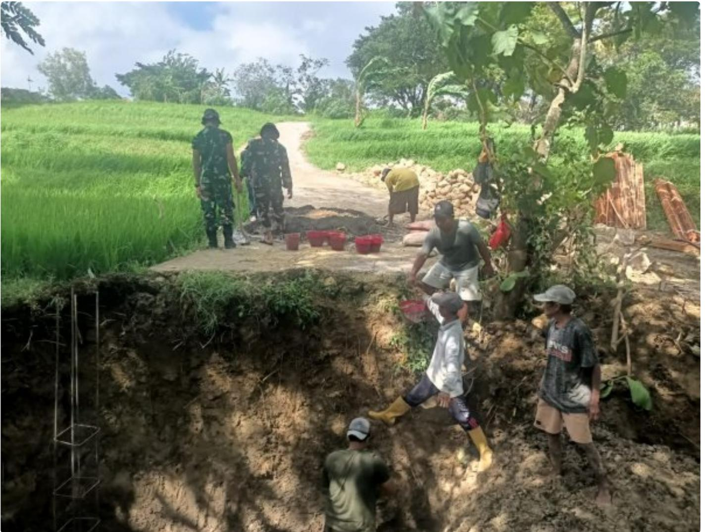
BANGKALAN — Satuan Tugas (Satgas) TNI Manunggal Membangun Desa (TMMD) ke 123 Kodim 0829/Bangkalan yang berada di Desa katol Timur, Kec. Kokop saat ini pada sasaran jembatan ke 2 berjalan di tahapan pemasangan tiang penyangga pondasi jembatan dilanjutkan dengan pengecoran pondasi, Jumat (21/2/2025).
